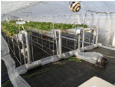
写真4 送風分配装置の設置状況
